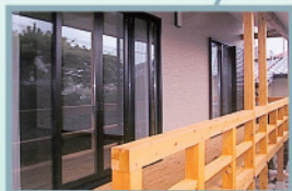
ウッドデッキ設置したい
